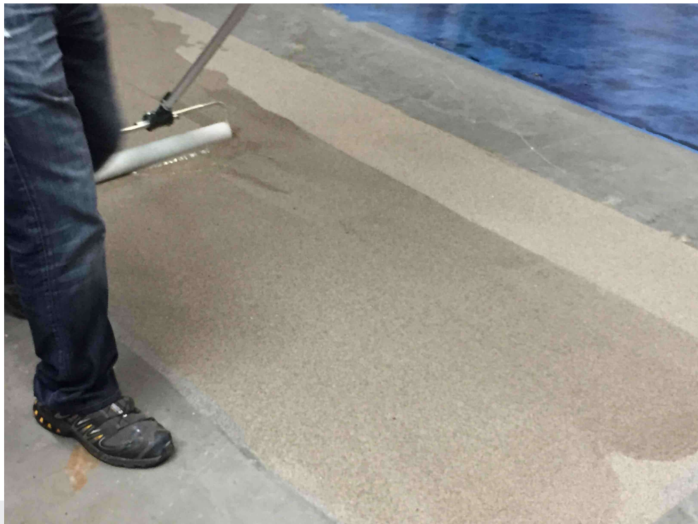
Foto: Aanbrengen primer.
