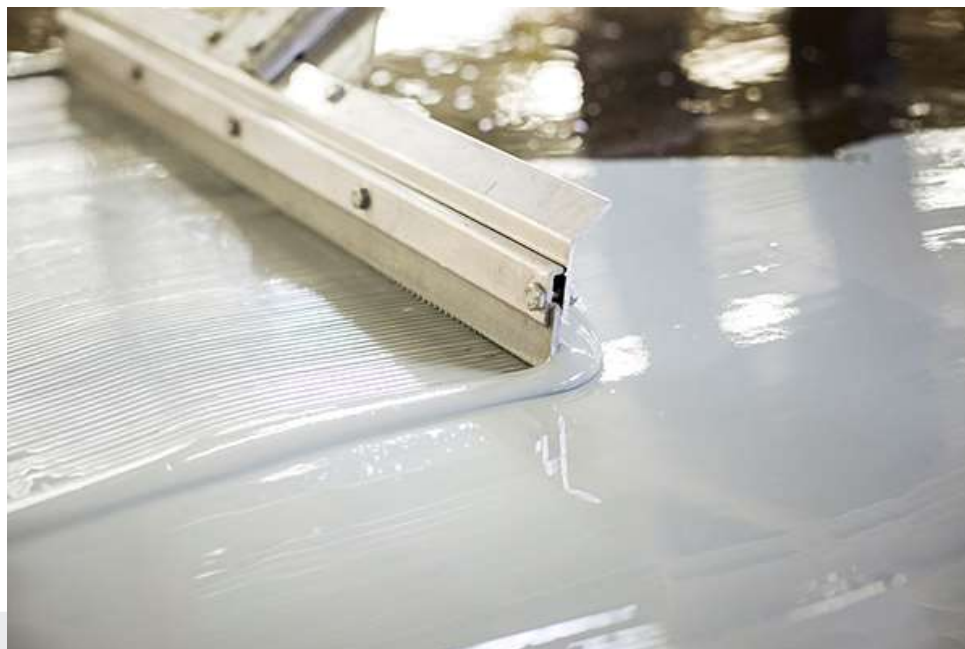
Foto: Aanbrengen vloeistofdichte beschermlaag.
